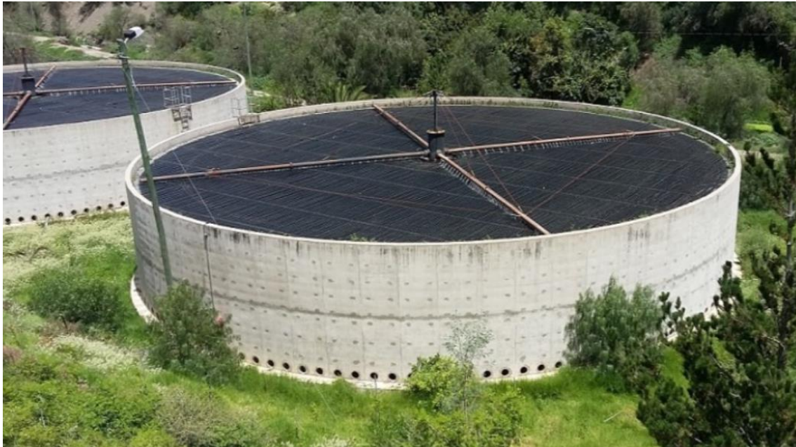
Figura 5 Imagen representativa – Lechos Percoladores.
