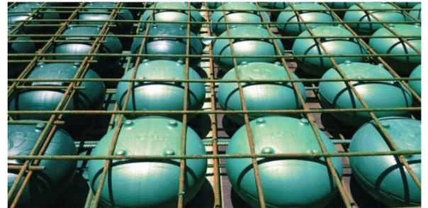
Imágenes de referencia sistema PrenoVA. Espesor final de losa terminada: 20 cm
