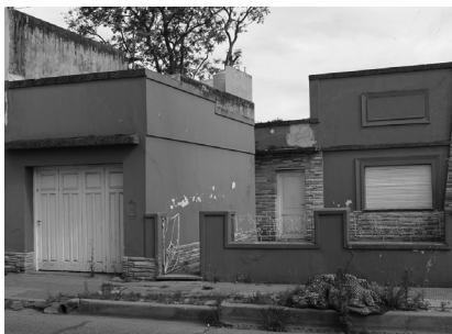
Propiedad 8 de junio 931 - Foto actual Actualmente funciona el “Ken Gad Manela”
