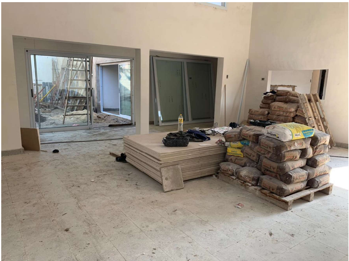
Centro de Desarrollo de la Niñez en construcción
