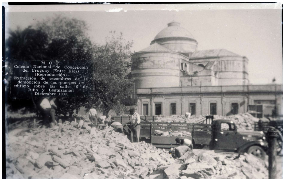
Tareas de demolición, 1939 (Fuente: CEDIAP).
