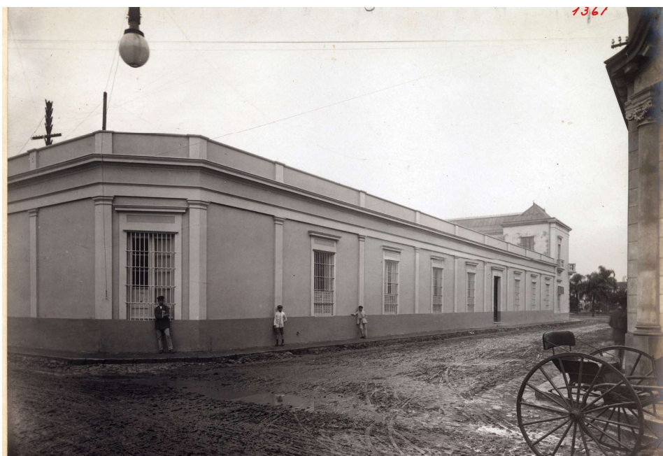
Vista de la esquina Sur-oeste, principios del siglo XX (Fuente: CEDIAP).
