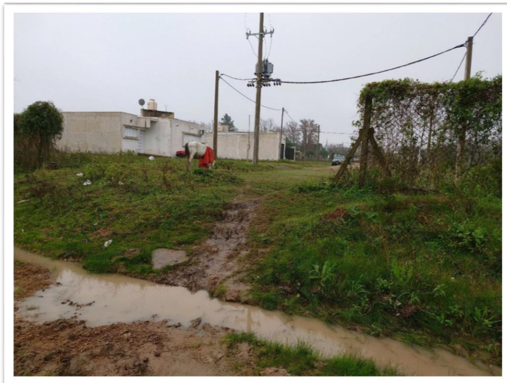
Figura 53 - Sitio de la Estación de Bombeo Barrio La Internacional
