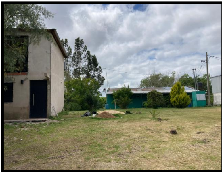
Figura 44 - Registro fotográfico: Vivienda 2
