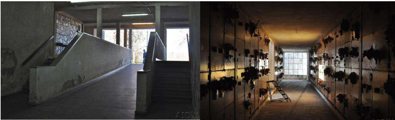
Rampa de ingreso y sector de bóvedas subterráneas. Fotografía obtenida de la Colección Particular de libre acceso Federico Negroni. Fuente: http://www.aidfadu.com/
