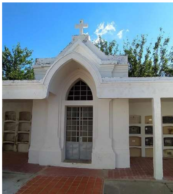
Antigua capilla (hoy desafectada)
