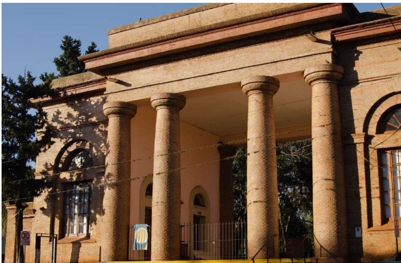
Pórtico de ingreso cementerio "La Piedad" – foto Estudio fotográfico Chas 35
