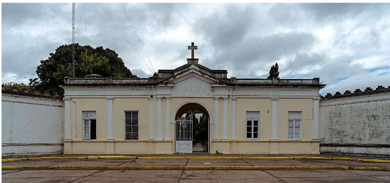
Pórtico del acceso principal sobre la calle Tulio Spinetti
