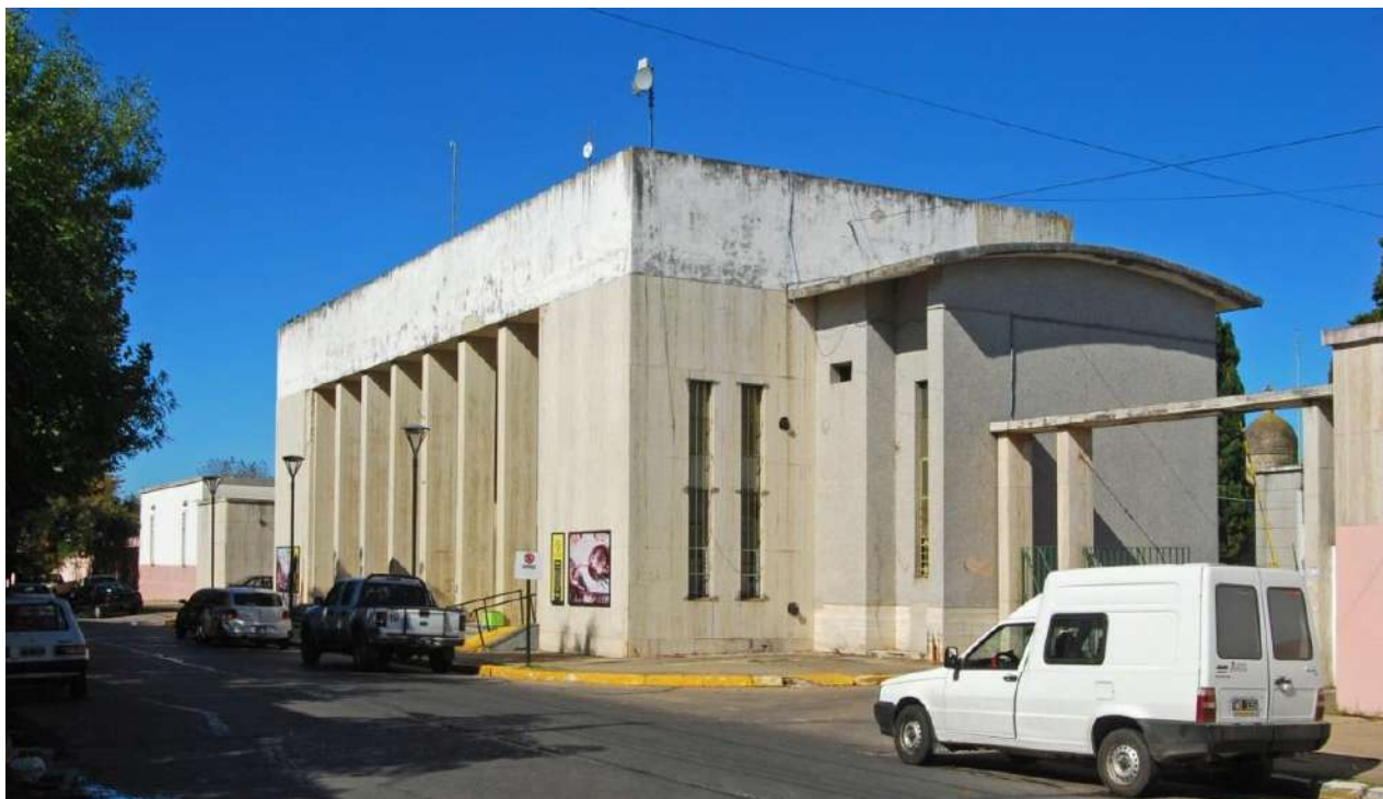
Pórtico de ingreso sobre Laguarda N° 1050, Ezpeleta
