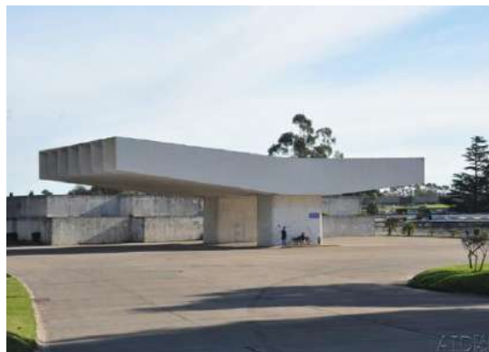
Explanada de cortejos semicubierto. Fotografía obtenida de la Colección Particular de libre acceso Federico Negroni. Fuente: http://www.aidfadu.com/
