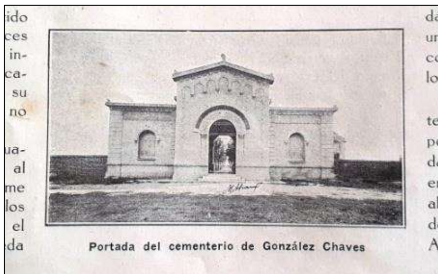
Álbum de Gonzales Chaves (1929), donde se aprecia el portal con las mismas características actuales
